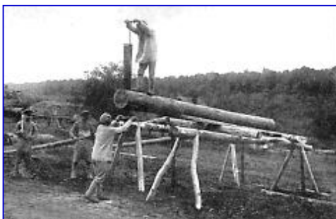
Рис. 1. Процесс пилки бревна на доски
